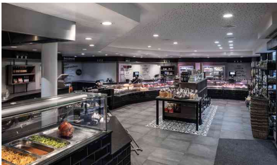
Die Metzgerei Berchtold in Rotkreuz setzt als innovativer Betrieb auf klimafreundliche Kälteanlagen. (Bild: Metzgerei Berchtold)
